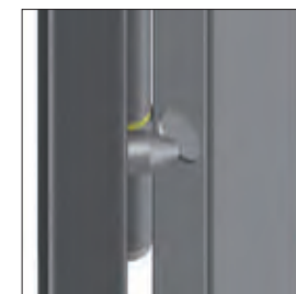
Rostri sul lato delle cerniere sono presenti i rostri
